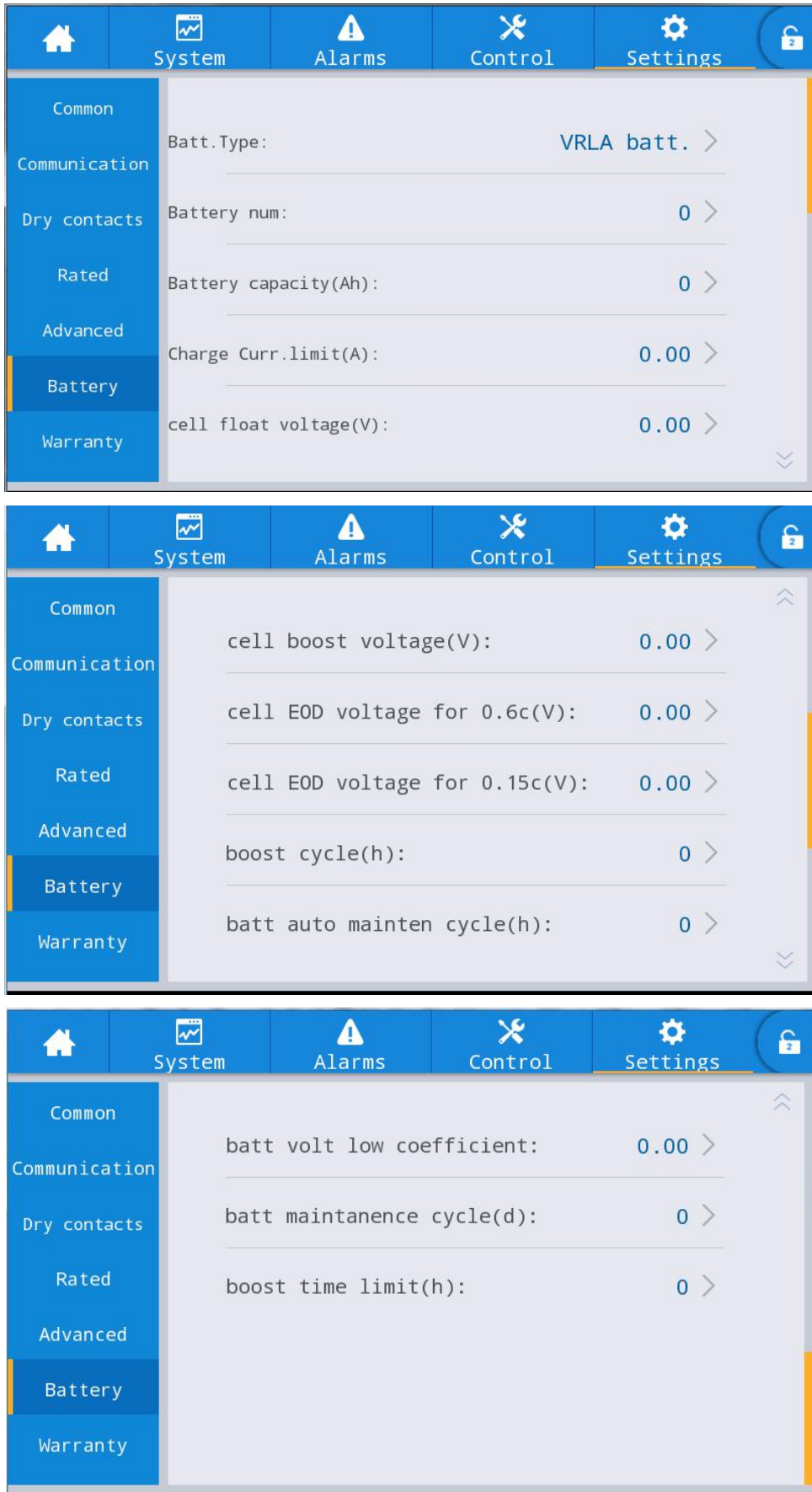
Fig. 4-19 Battery parameters interface
