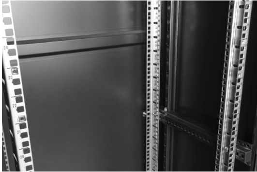
- zamontować koszyki pod śruby M6
