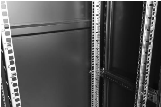
- zamontować koszyki pod śruby M6
