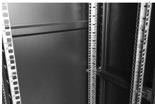
- zamontować koszyki pod śruby M6
